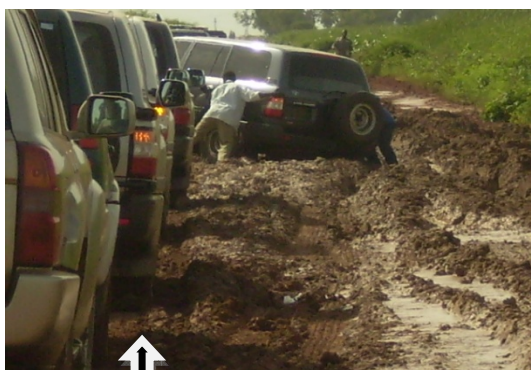
Une illustration de l'état assez dégradé de la route en période hivernale.
