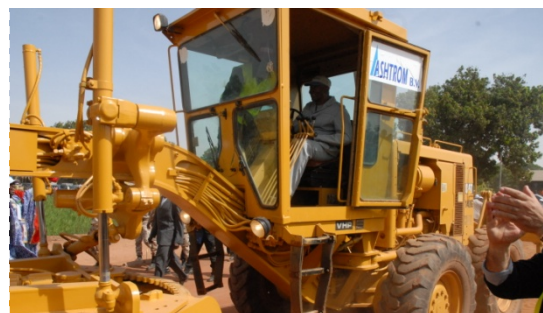
S.E Mr le Président de la République donnant le coup d'envoi des travaux de la route.
